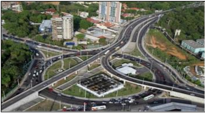
Figura 3. Complexo Viário Gilberto Mestrinho Fonte: [11].
