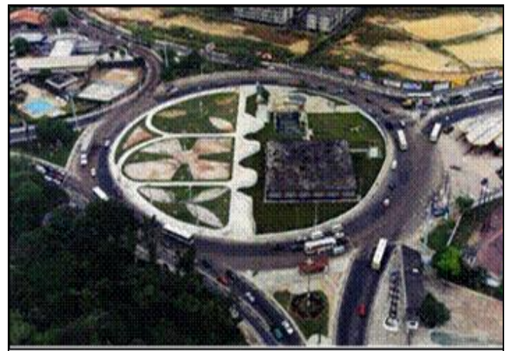
Figura 2: Rotatória do Coroado sem as alças superiores e a passagem subterrânea.
