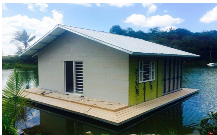
Figura 2: Casa flutuante construída pelo sistema Light Steel Frame na cidade de Manaus, AM. Fonte: Planalto Industrial Ltda. Fonte: Autores, (2018).
