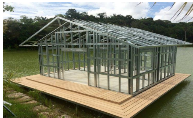
Figura 1: Estrutura metálica em perfil de aço galvanizado da casa flutuante construída pelo sistema Light Steel Frame. Fonte: Planalto Industrial Ltda. Fonte: Autores, (2018).
